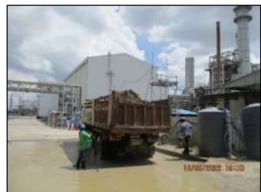
รูปที่ 2-3 การทำความสะอาดล้อรถบรรทุก
