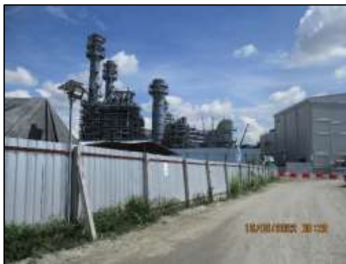
รูปที่ 2-5 การกั้นเขตพื้นที่ก่อสร้าง
