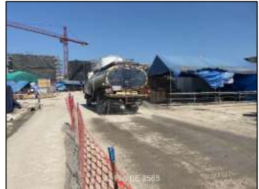
รูปที่ 2-1 การฉีดพรมน้ำบริเวณที่ก่อสร้าง
