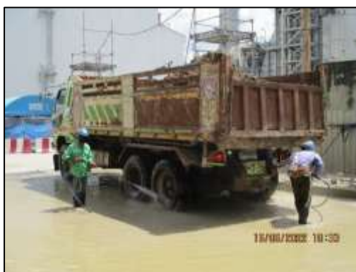
รูปที่ 2-3 การทำความสะอาดล้อรถบรรทุก
