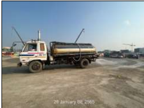
รูปที่ 2-1 การฉีดพรมน้ำบริเวณที่ก่อสร้าง
